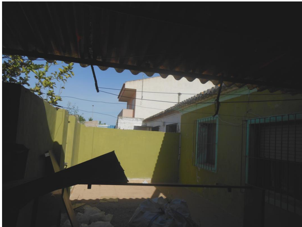
PATIO PERTENECIENTE A LA VIVIENDA EN ESQUINA
