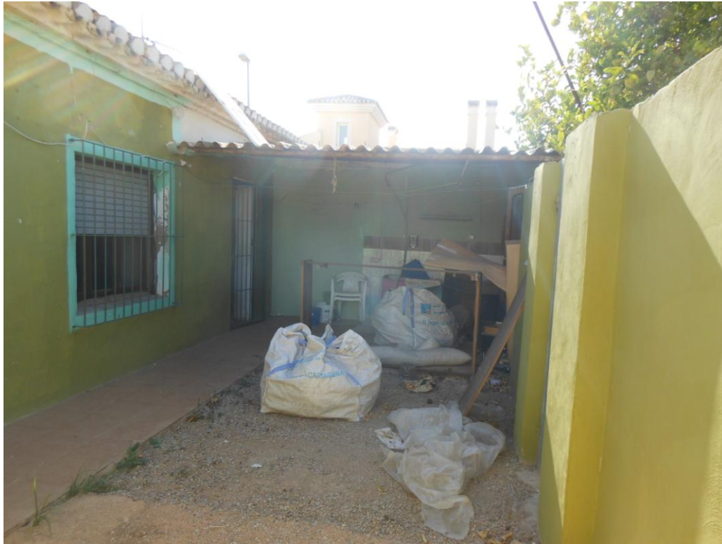
PATIO PERTENECIENTE A LA VIVIENDA EN ESQUINA
