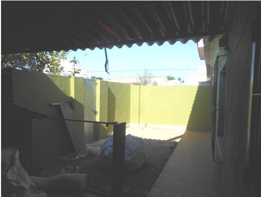
PATIO PERTENECIENTE A LA VIVIENDA EN ESQUINA
