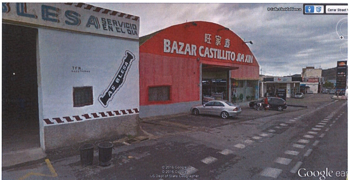
Fotos de situación actual de la unidad de actuación. (Google Earth)
