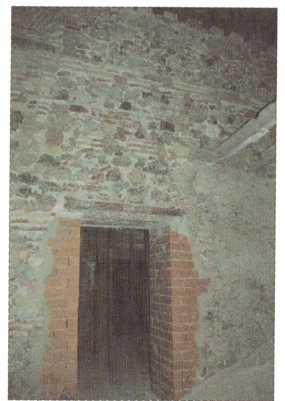
IMAGEN 08: MURO CENTRAL EN BUEN ESTADO DE CONSERVACIÓN. HUECO CON JAMBAS REALIZADAS CON FÁBRICA MODERNA SUSCEPTIBLE DE PEQUEÑA AMPLIACIÓN PARA PASO DE PERSONAS
