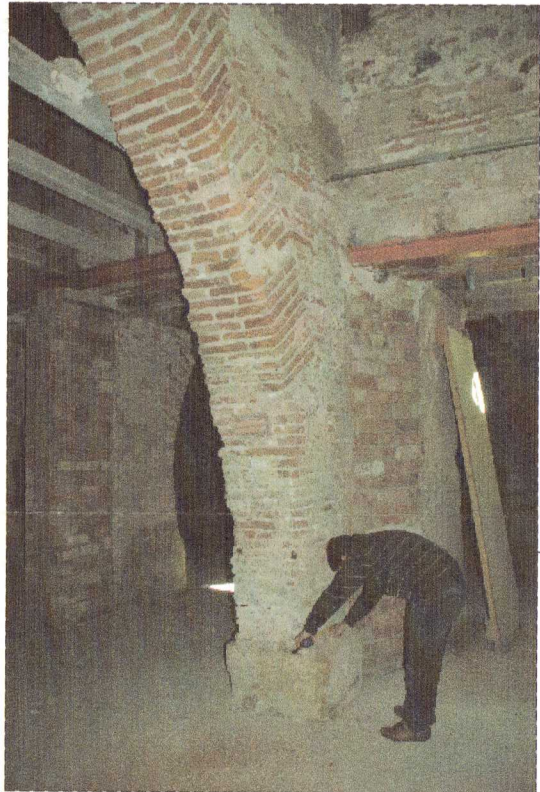
IMAGEN 02: DETALLE PILASTRA ARRANQUE ARCO
