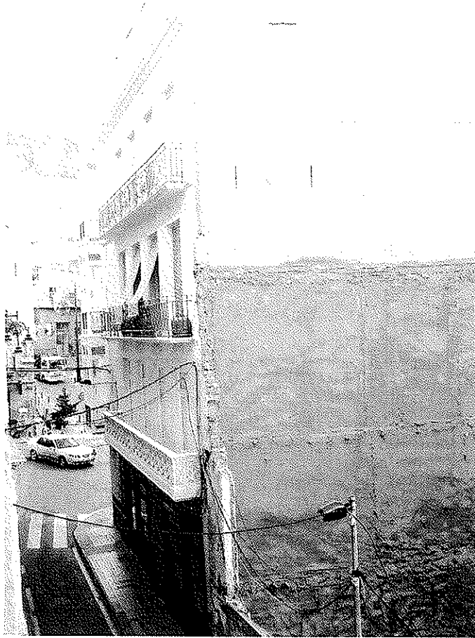
Vista de la medianera donde se aprecia el resultado de realizar un edificio de B+2 plantas
