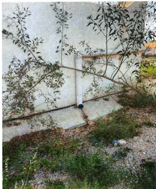
Fotografía 6. Desagüe a la parcela objeto del Estudio de Detalle de la tubería que recoge las aguas pluviales de la cubierta inferior de la nave de la Iglesia
