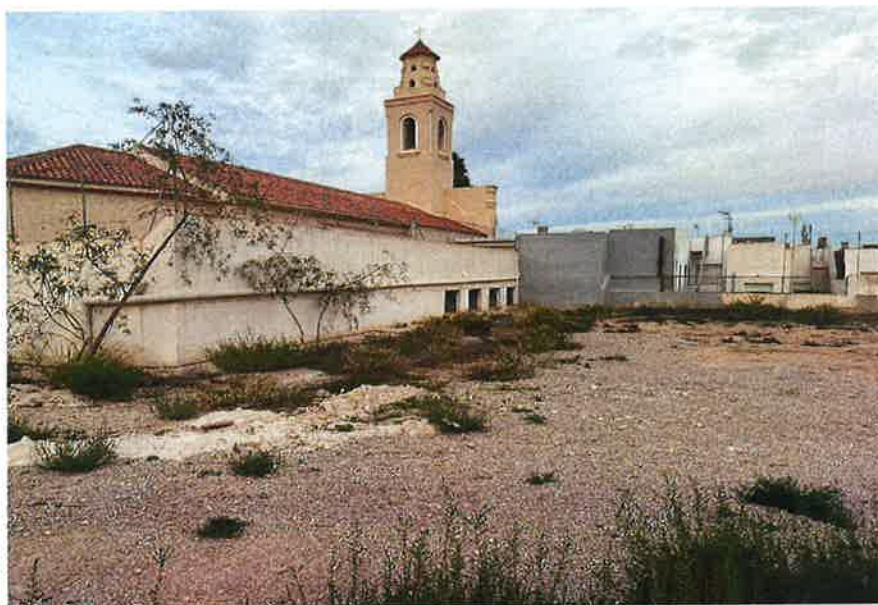
Fotografía 5. Huecos existentes en la medianera compartida con la nave de la Iglesia sita en la manzana catastral 67382 y tubería que recoge las aguas pluviales de la cubierta inferior de la nave.
