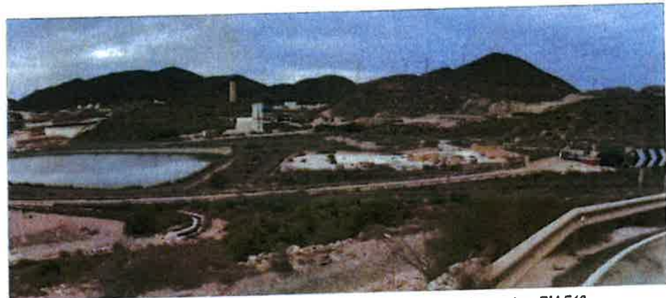
Imagen 13.- Vistas hacia las instalaciones desde punto 1, desde la carretera RM-F46
