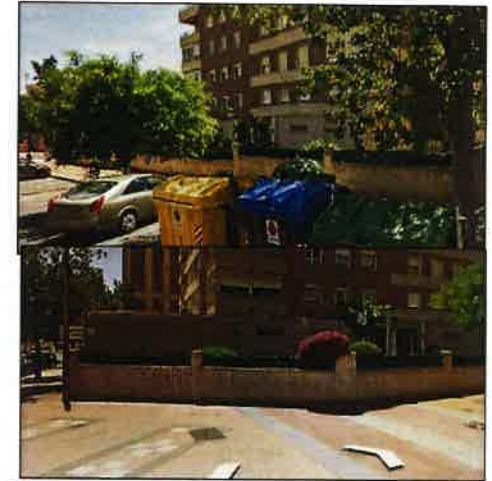
VALLA BAJA Y PERMEABLE - ACCESO A UN ESPACIO ABIERTO DE UN EDIFICIO RESIDENCIAL COLECTIVO
