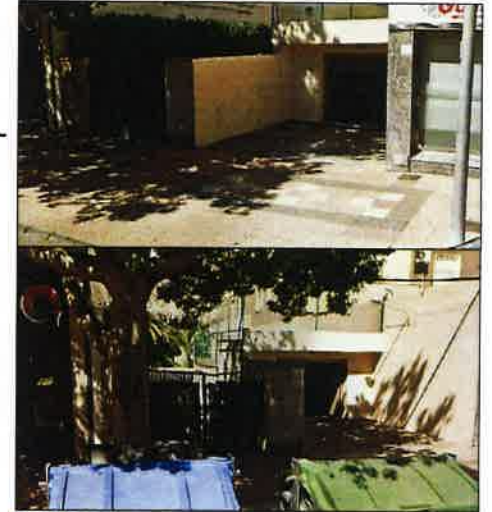
PUERTA PERMEABLE DE ACCESO AL JARDIN COMUNITARIO PUERTA DE VEHICULOS SIN GUARDAR ALINEACION DE FACHADA
