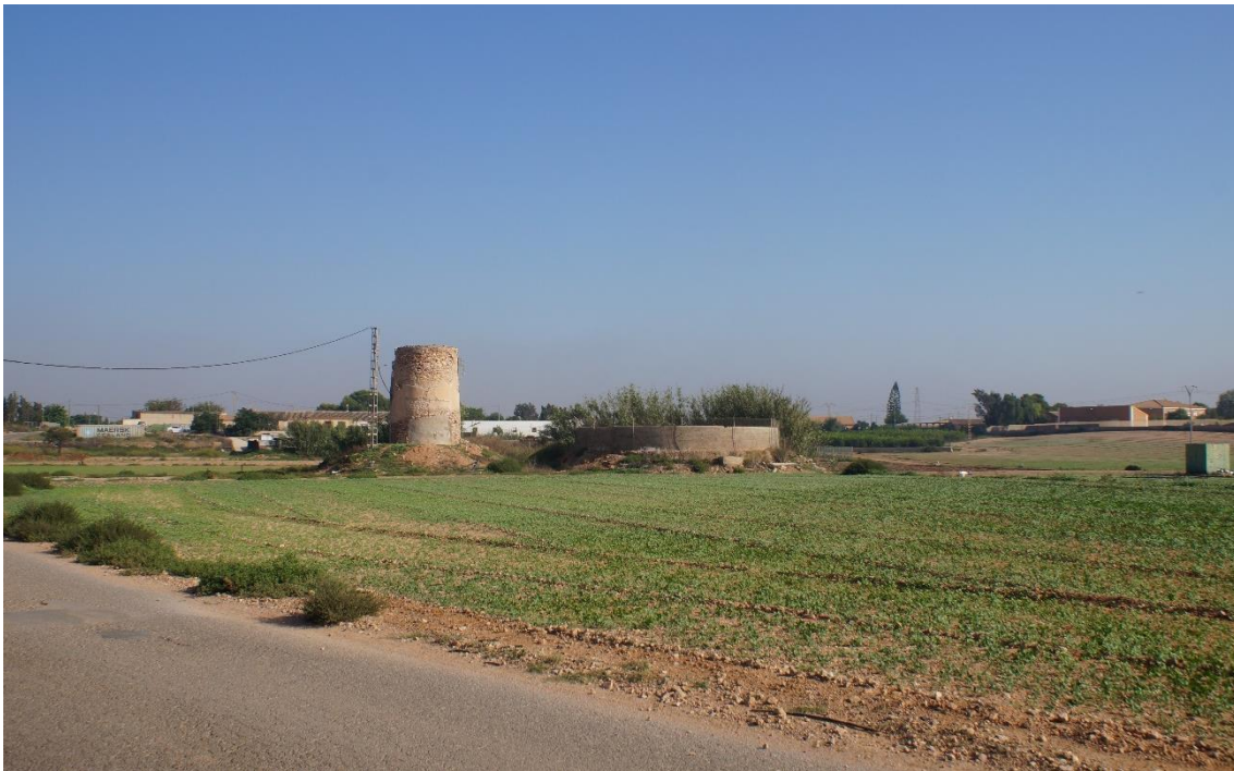
Fotografía 9. Base estructural del molino de viento Inventariado Nº47 y balsa adyacente.
