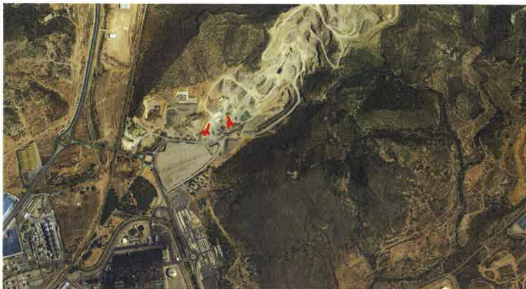
Figura 1.- Situación de las Plantas de Hormigón y Asfalto sobre fotografía aérea.
