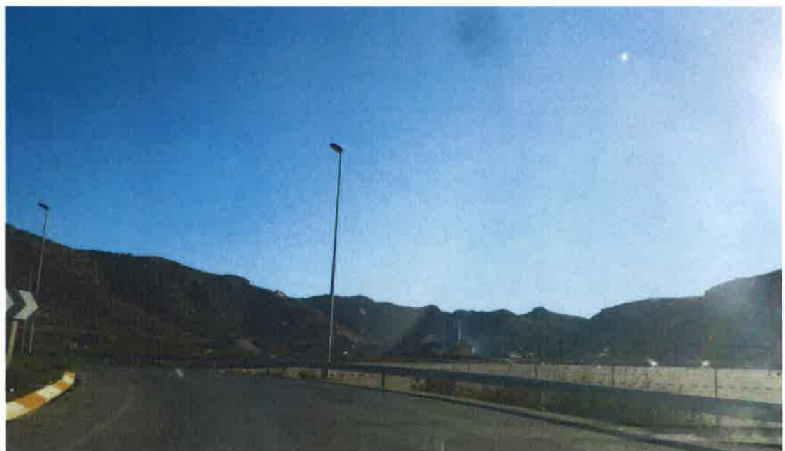
Fotografía 2.- Imagen tomada desde el Punto de Observación 1, la carretera regional RM-320 en dirección a las Instalaciones, donde se aprecia la Planta de Hormigón con el Pico de la Miguelota y del Horcado de fondo.
