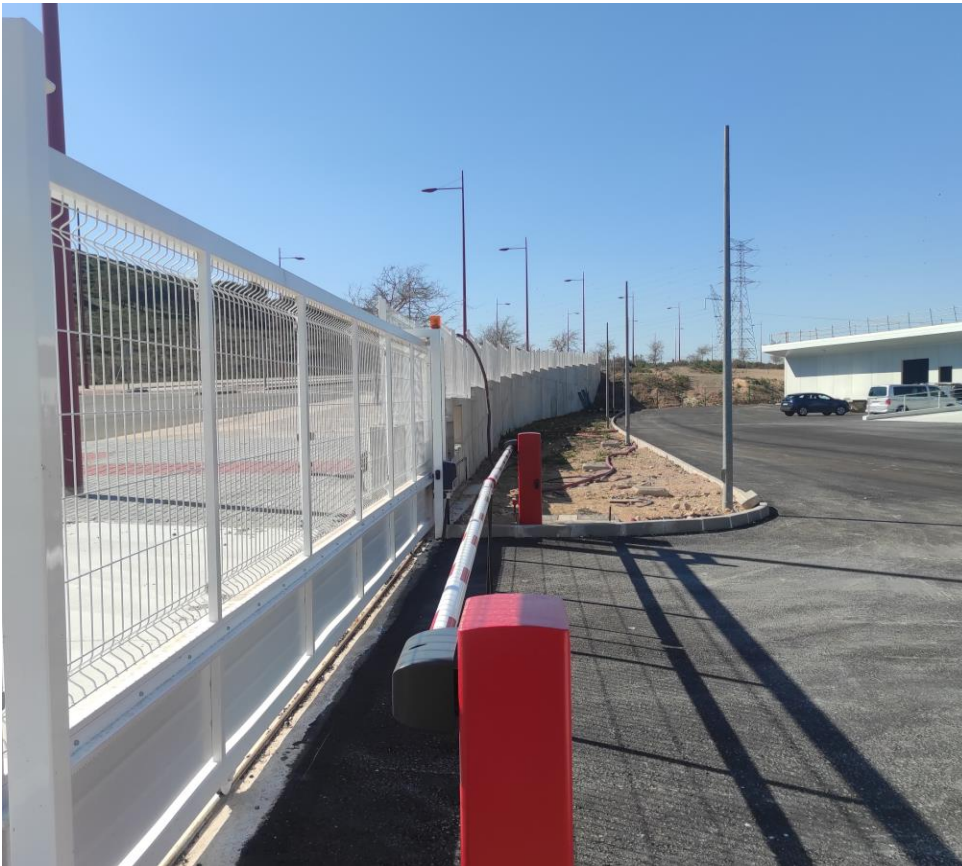
Acceso a nave existente en cota +105,00
