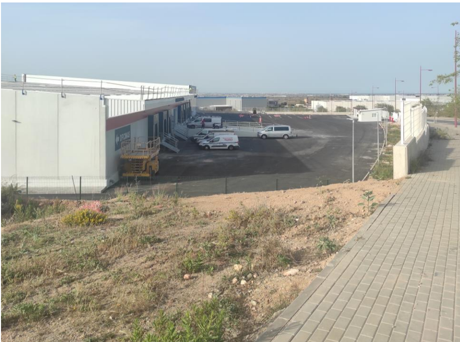
Desnivel desde la cota +114,00 en calle Hidrógeno
