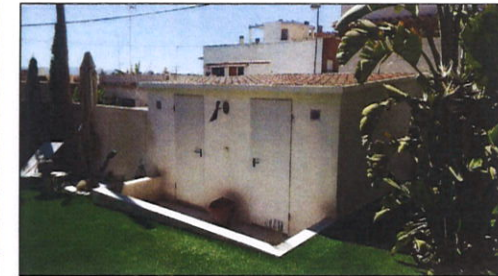
Trasteros / sala de máquinas
