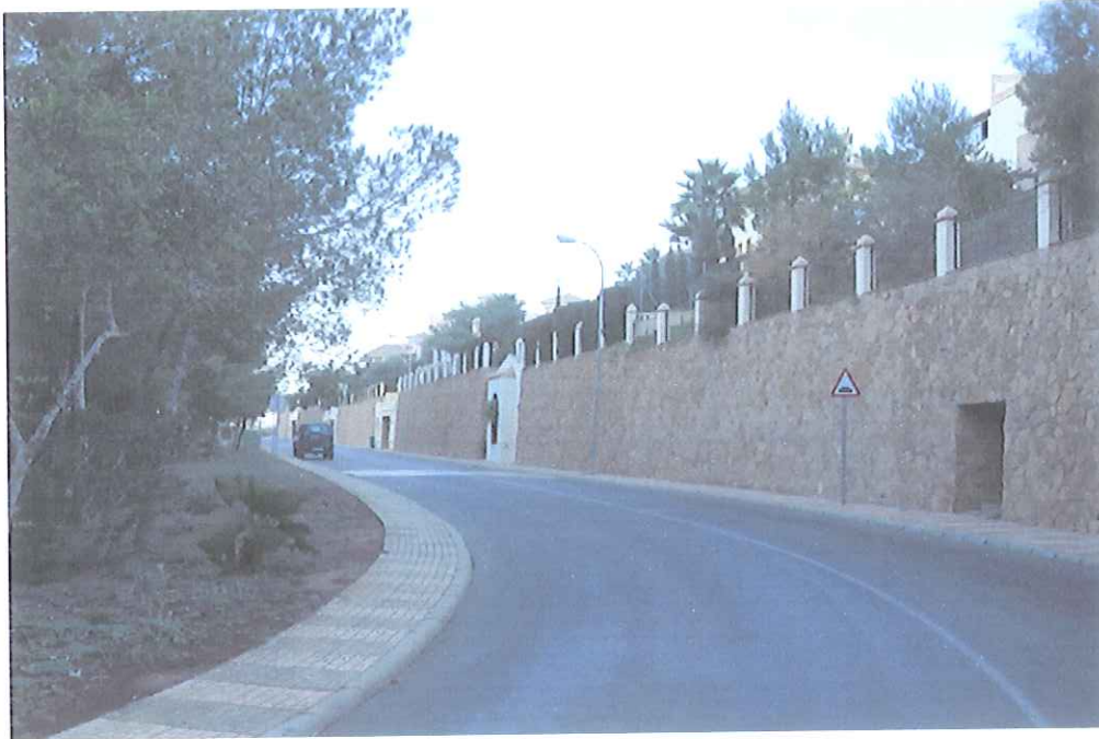
(Foto 4) Muro de cierre de 4 a 5 m de altura aproximadamente ocupando toda la longitud de la calle, prácticamente unos 300 metros.
