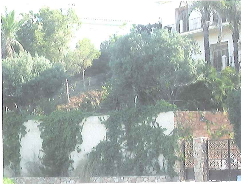
(Foto 2) Muro de cierre de 4 m de altura aproximadamente.
