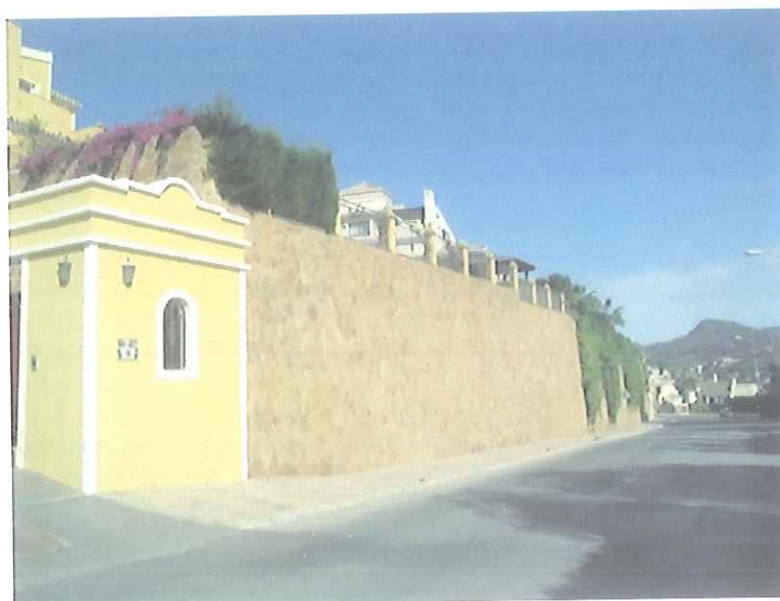
(Foto 3) Muro de cierre de 5 a 6 m de altura aproximadamente.
