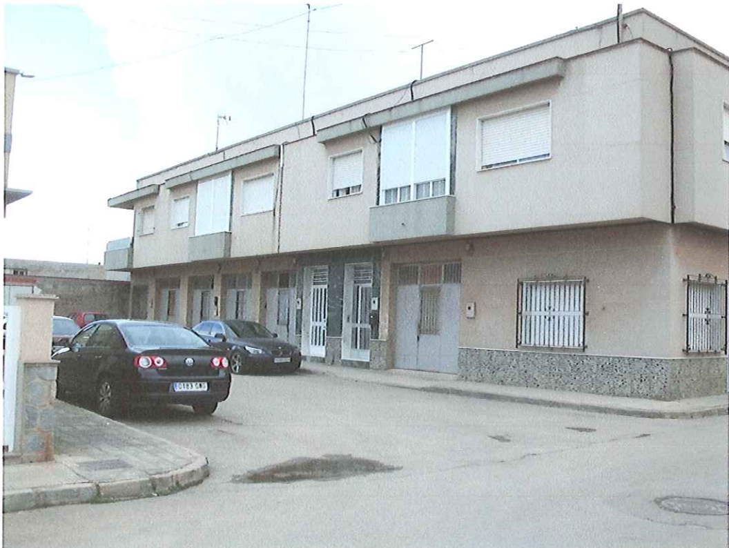
FOTOGRAFIA DE FACHADA LATERAL DERECHA DE LA TRAVESIA
