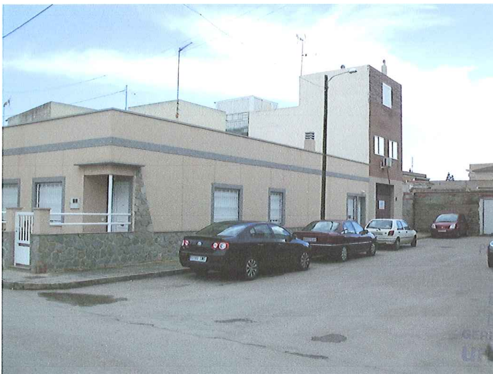
FOTOGRAFIA DE FACHADA LATERAL IZQUIERDA DE LA TRAVESIA
